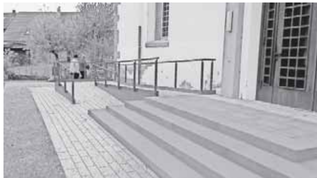
Erstmal genutzt wurde auch die neu errichtete Rampe, welche es nun auch Rollstuhlfahrer und Gehbehinderten ermöglicht, barrierefrei in die evangelische Kirche Vörstetten zu gelangen um an den Gottesdiensten teilzunehmen.
